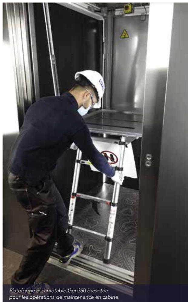
Plateforme escamotable Gen360 brevetée pour les opérations de maintenance en cabine
